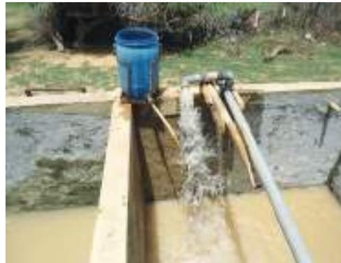
*Injection de sulfate d'alumine, station de Tékane (Mauritanie)*
