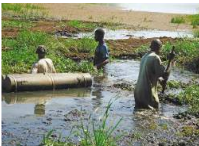
Évacuation de typha auprès d'une prise d'eau brute
