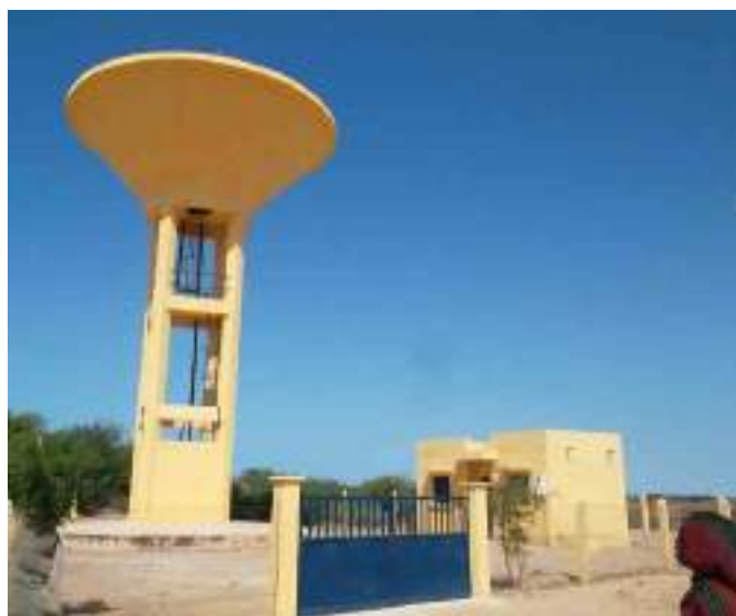
Station de potabilisation de Mboubène
