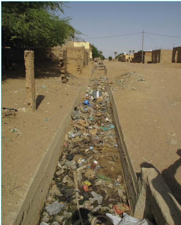
Photo 6 - Canal d'évacuation des eaux de pluie de la ville de Boghé obstrué par le sable et les déchets, avant son curage par la municipalité
